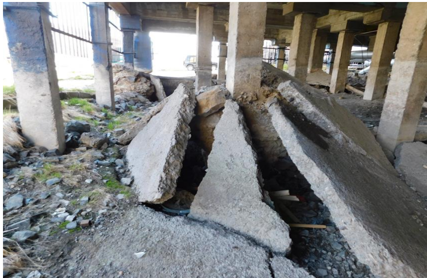
Рис.2 Термокарстовая чаша протаивания под жилым домом.
